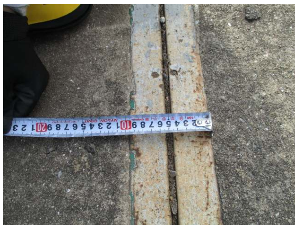
신축이음 유간거리 측정
