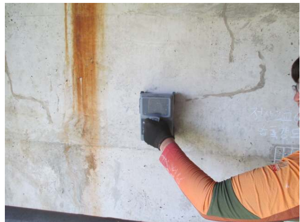
철근 피복두께 측정
