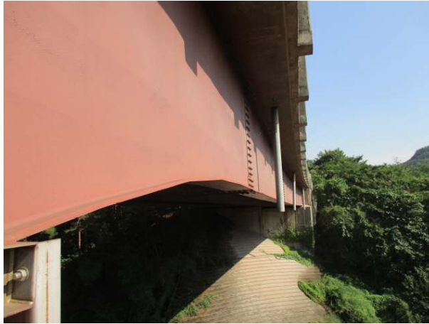
Steel Box 전경
