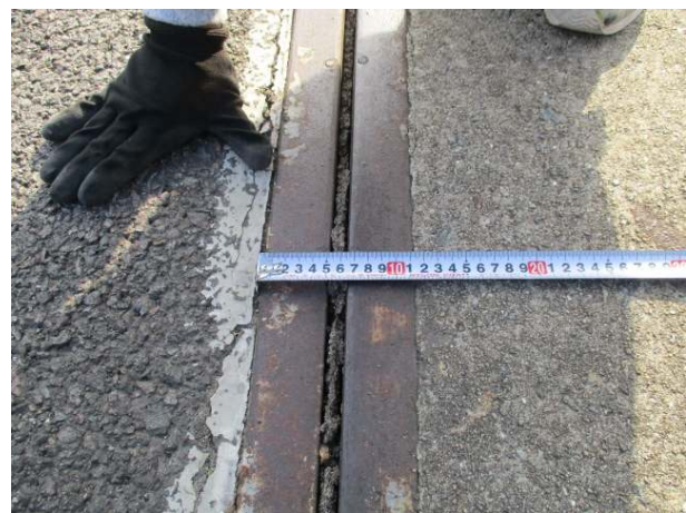
신축이음 유간거리 측정
